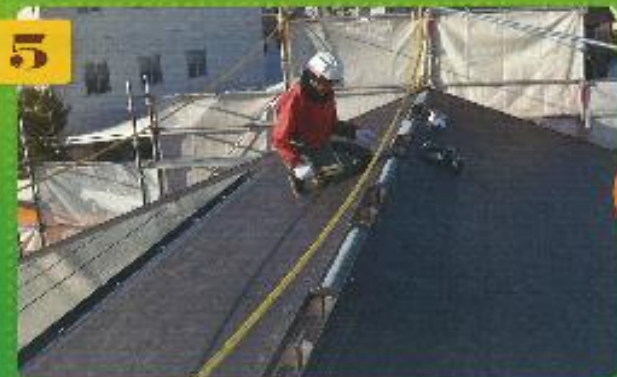
周囲の屋根材を葺きます
