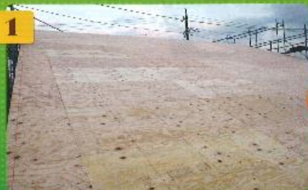
屋根の野地板を張ります
