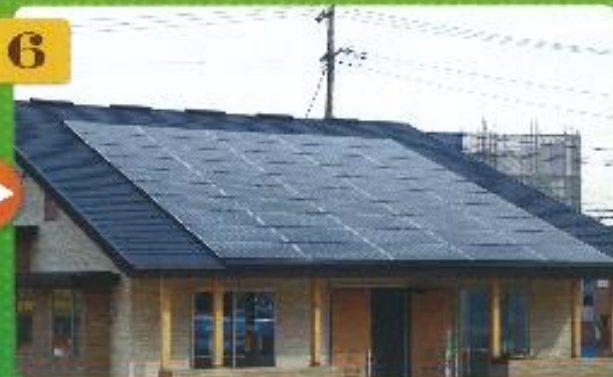
漏水面と通気性に優れた太陽光パネルの取付け完成です
