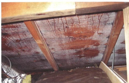
北側の野地合板だけにカビが生じていた事例。吊り木や断熱材のまわりに隙間が多数見られる。60ページの図④に該当
