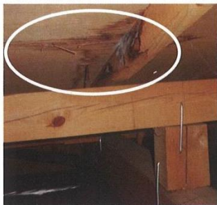
屋根に太陽光パネルを後付けした住宅で、パネルの下の野地合板やクギが結露していた事例。パネルを設置して6~7年が経過していた(写真・資料：特記以外は屋根システム総合研究所)
