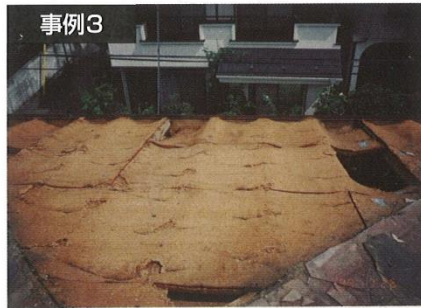
寄棟屋根で天井断熱を採用していた、東京都内に建つ築24年の 住宅。野地板に木片を固めてつくったボードを使っており、北側 だけが水分を含んで層状剥離を起こし粉状になっていた
