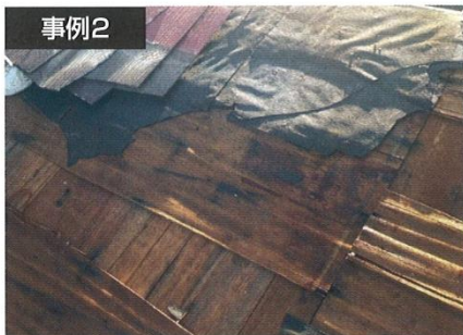
軒先に吸気孔を設けていた、東京都内に建つ築20年の住宅。北面 のアスファルトルーフィングを剥ぐと野地合板がぬれていて、ル ーフィングも野地合板も劣化でぼろぼろになっていた
