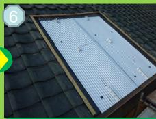
\_\_\_\_\_\_ スマピタを施工します。軽量で通気 性もあります。
