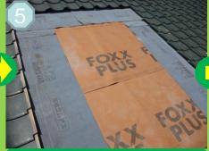
透湿ルーフィングを施工し、雨水を 防ぎ湿気は逃がします。
