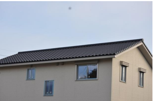
⑩ホールレス工法・完成。
