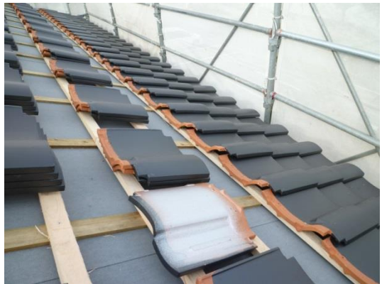
⑨遮熱瓦・クールスペックで施工。
