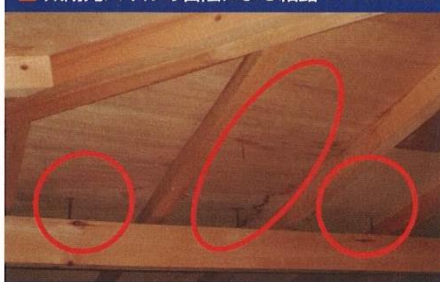
■ 太陽光パネルの日陰による結露 (8月号の本連載)
