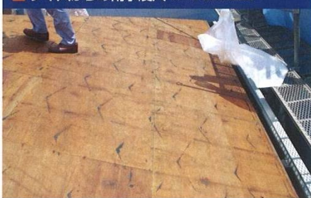
■ クギ穴からの雨水浸入 (11月号の本連載)
