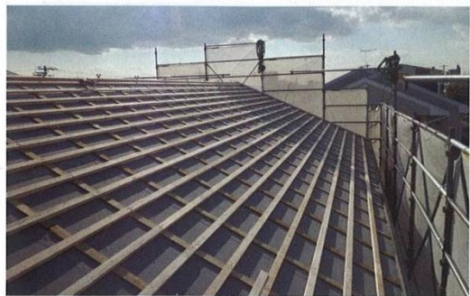
愛知県高浜市で12年1月に完成したホールレス工法の施工例。左はルーフィングに縦桧と横桧を設置した状態、下は横桧に瓦を留めている状態
