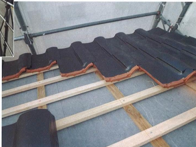
愛知県高浜市で12年1月に完成したホールレス工法の施工例。左はルーフィングに縦桧と横桧を設置した状態、下は横桧に瓦を留めている状態
