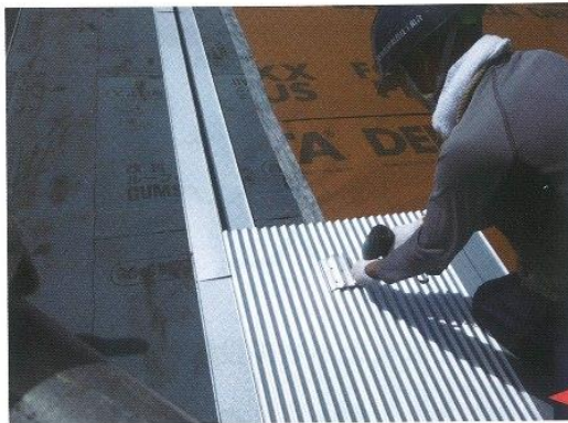
④ 取付金具のついた波形ベース板をビスで固定
