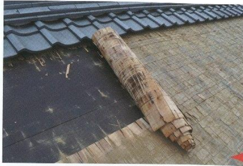
② 既存の野地の状態を確認 ここでは葺き板を撤去
