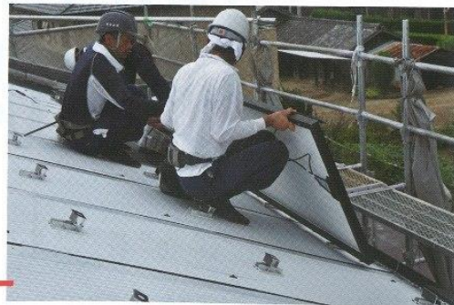
⑤ 太陽光パネルの配線を取付金具でまとめる
