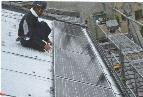
⑥ 太陽光パネルを取付金具で固定する
