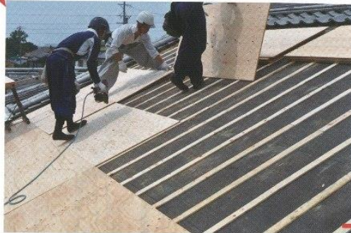
③ 椽木をおき合板の増し張りをして強度をとる
