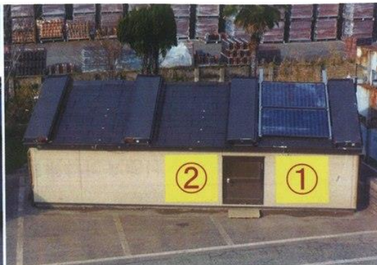
パネル設置後 (②化粧スレート、①太陽光パネル設置)
