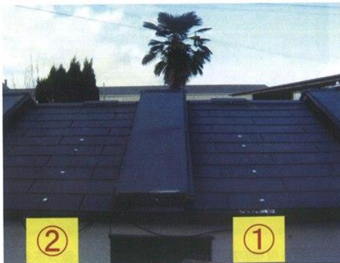
パネル設置前 (①②共に化粧スレート)
