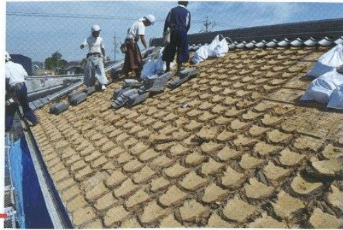
① 土葺き屋根の施工 瓦をめくり葺き土を撤去する
