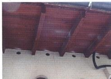
(写真6) 新たに設けた吸気口
