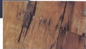
左はスレートを留めたクギの頭部が結露してさびが出ている様子。60ページの図⑦に該当。下は野地合板を垂木に留めたクギ頭部がさびて、クギまわりの合板が黒ずんでいたセメント瓦葺きの住宅。同図⑤に該当
