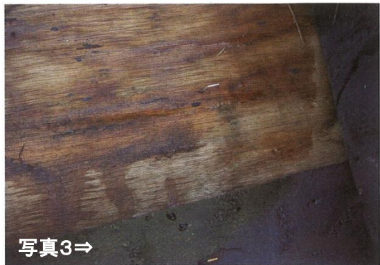
野地合板の上に結露が発生している様子。クギまわりの隙間から雨水が浸入することで起こる。右ページの図③に該当
