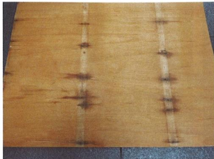
野地合板の上に結露が発生している様子。クギまわりの隙間から雨水が浸入することで起こる。右ページの図③に該当
