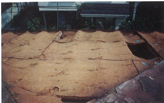
築24年の住宅で、北側の野地合板が水分を含んで層状剥離を起こしている様子。日射の当たる南面の野地合板から放出された湿気が外気に十分排出されず、温度の低い北側の野地合板に回ったと考えられる。60ページの図③④に該当
