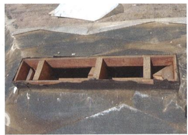
事例2 東京都内に建つ築27年の住宅。北面の野地合板だけが腐 食し、踏みと危険な状態だった。天井断熱で、軒先と棟に 吸気孔と排気孔を設けていた (写真：特記以外は屋根システム総合研究所)
